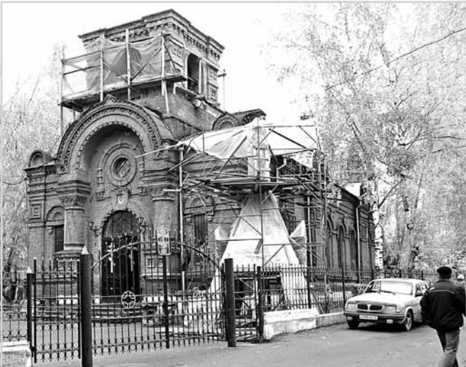
Петропавловская церковь, восстановление колокольни, 2006 г.
